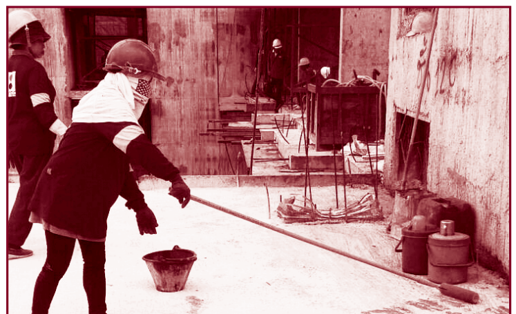
การทำสารเคมีลงบนพื้นผิวคอนกรีตเพื่อป้องกันน้ำในคอนกรีตระเหย
