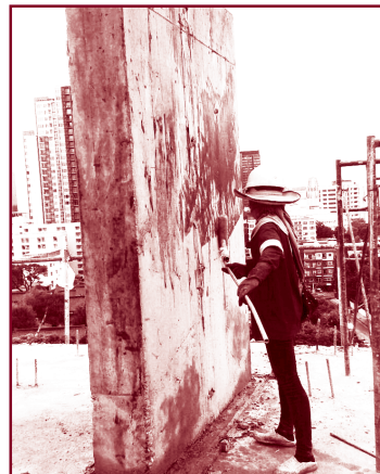
กระสอบป่าน มักถูกนำมาใช้ในการบ่มคอนกรีตในประเทศไทย
